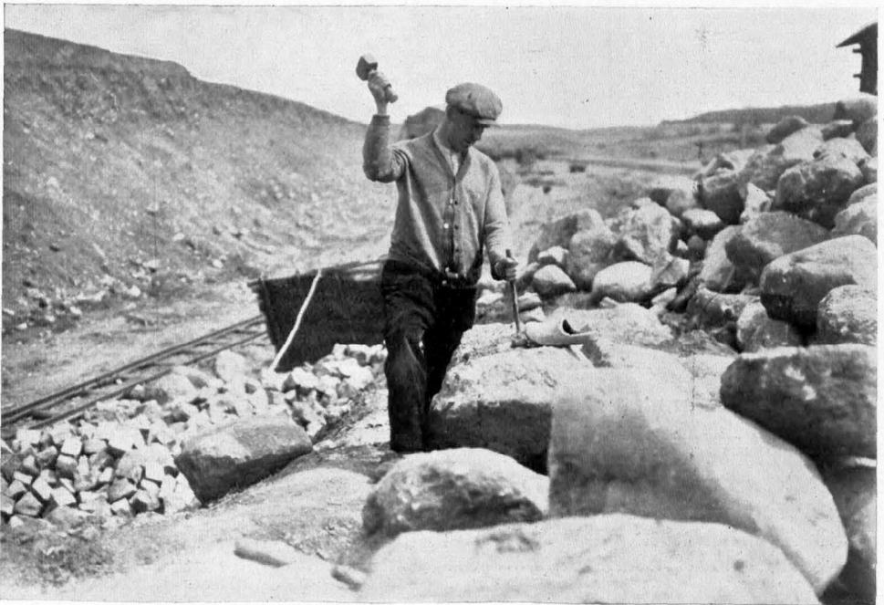
Abb. 6. Grube Amt Grimnitz. In den Findling wird ein Sprengloch gemeißelt.
